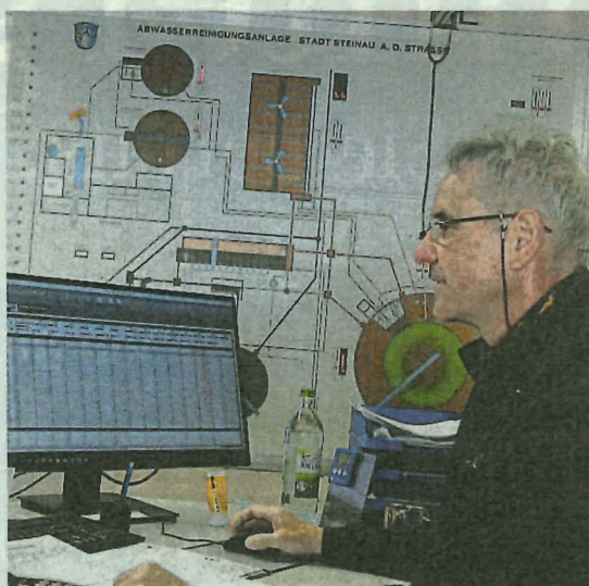
Kläranlagenleiter Paul Krack hat in der Schaltzentrale des Steinauer Klärwerks den Überblick über alle wichtigen Funktionen.
